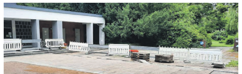
Aktuell schreiten die Arbeiten zur Neugestaltung des Platzes an der Rotthausener Trauerhalle zügig voran. Foto: Georg Gerech
