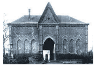
Die alte Trauerhalle (hier die Rückseite) war bei der Eröffnung 1893 der südliche Eingang zum Friedhof. Vor 50 Jahren wurde sie abgerissen und durch einen Neubau ersetzt, der allerdings auch schon Bergschäden aufweist.
